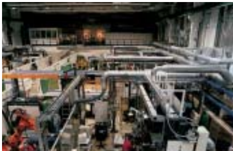
Blick in die Technikumshalle des IWS
